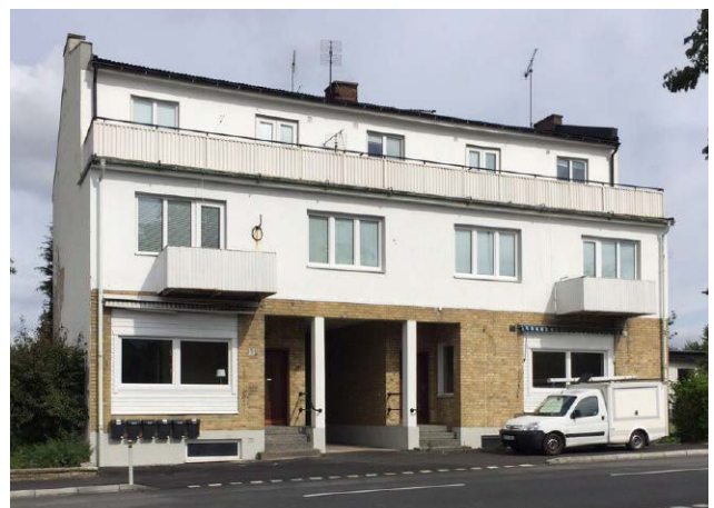
Fastigheten i Bjärnum med 6 lägenheter. Tidigare uppvärmd med fjärrvärme. Ny värmepump hösten 2017, GEO222. Tidigare energiåtgång 105 000 kWh fjärrvärme. Beräknad elförbrukning med IVT värmepump 30 000 kWh.
